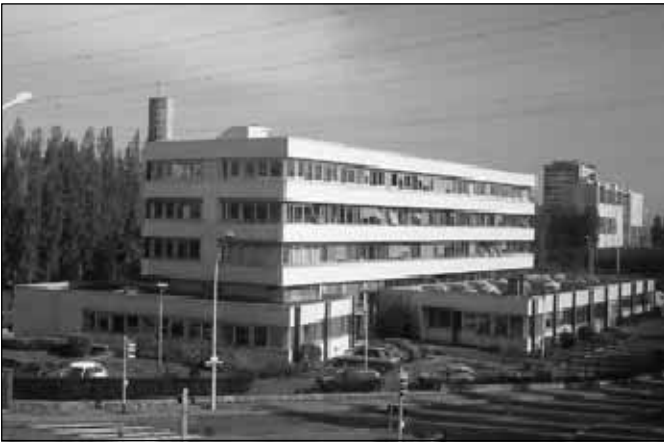
Head Office - Rosny sous Bois
